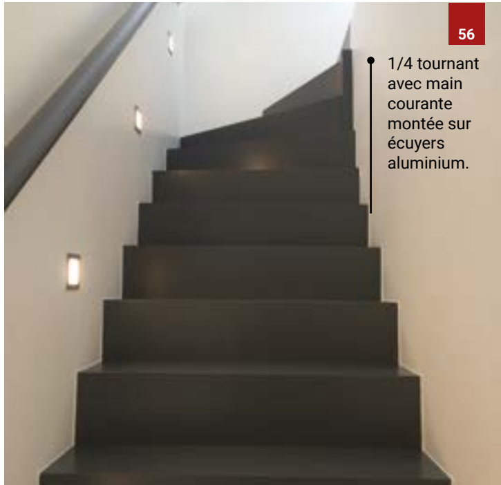
Escalier 1/4 tournant en hêtre ACM laquées et faux limons découpés dessus.
