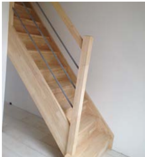
STRUCTURE LIMON À LA FRANÇAISE LIMON ET FAUX/LIMON
